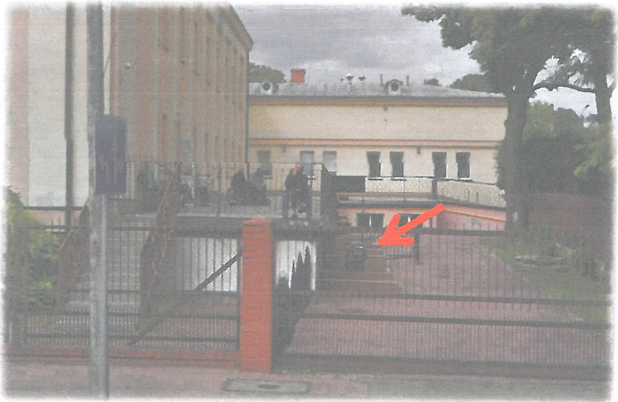
Rysunek 1. Widok terenu z oznaczeniem wejścia do kotłowni
